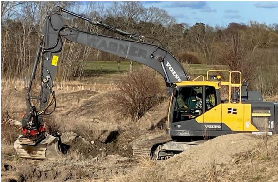
Grävning av provgropar
