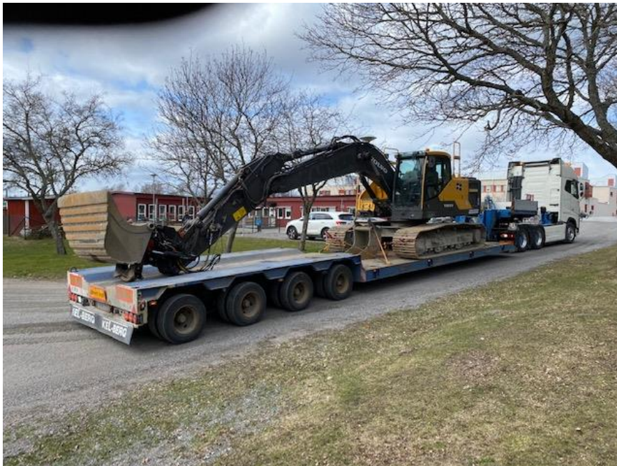
Etablering av grävare
