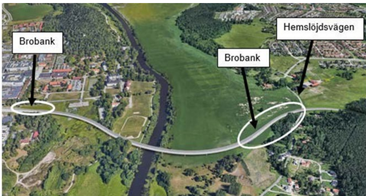
Figur 15. Visar bronns sträckning genom landskapet. Bron går först över en stor gräsplan, vidare över vegetationen runt Fyrisån, över den öppna vattenspegeln, över odlingslandskapet öster om bron och landar i bankar. Hemslöjdsvägen korsas med en bro. Bild av Rundquist arkitekter.
