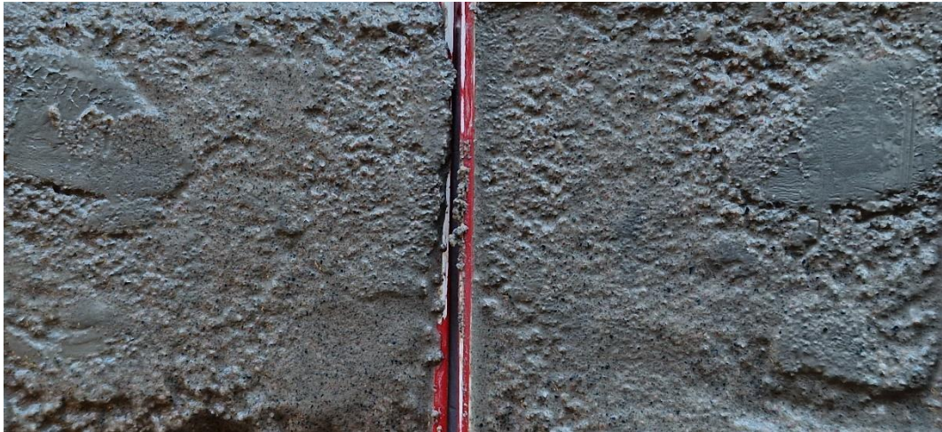
Figur 7 Borrpunkten, 23W021, 4,5 m, Jordprovet i nedre delen av mellanhylsan delad longitudinellt provhylsan med id Bjerking 1068.
