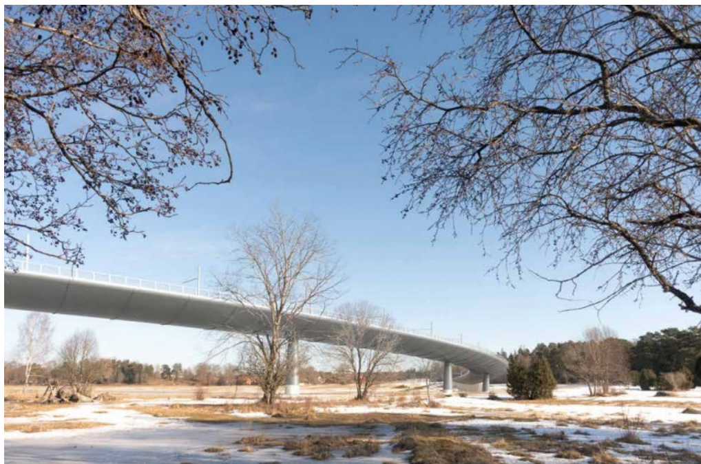
Figur 51: Fotomontage över en bro med tolv meter segelfri höjd där den går över land öster om Fyrisån. Utblick norrut, nära Fyrisån, strax söder om bron. Bild: Rundquist arkitekter.
