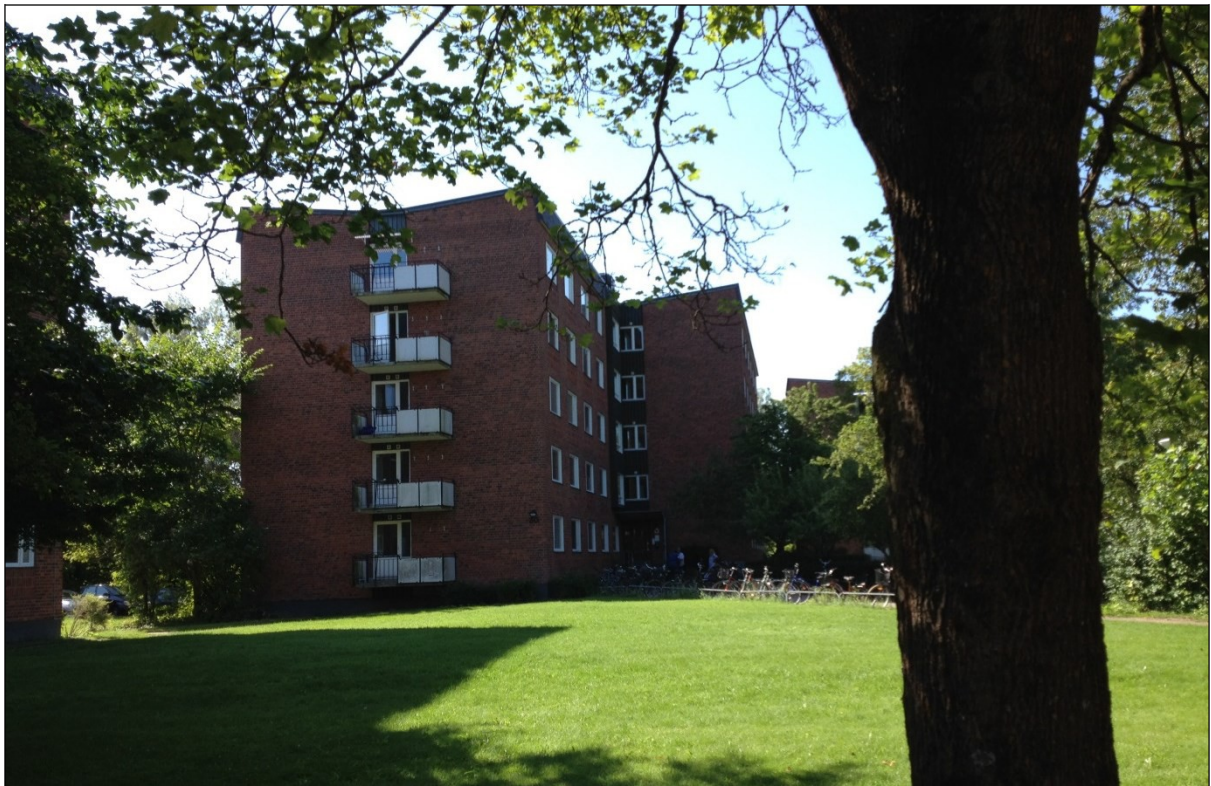
Ett av de tegelklädda röda lamellhusen i 5 våningar sett från innergården.
