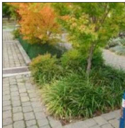
Exempel på hur parkering och köryta avvattnas mot växtbäddar. (Bilder från dagvattenutredningen).
