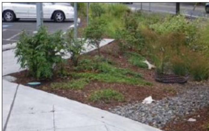
Exempel på hur parkering och köryta avvattnas mot växtbäddar. (Bilder från dagvattenutredningen).
