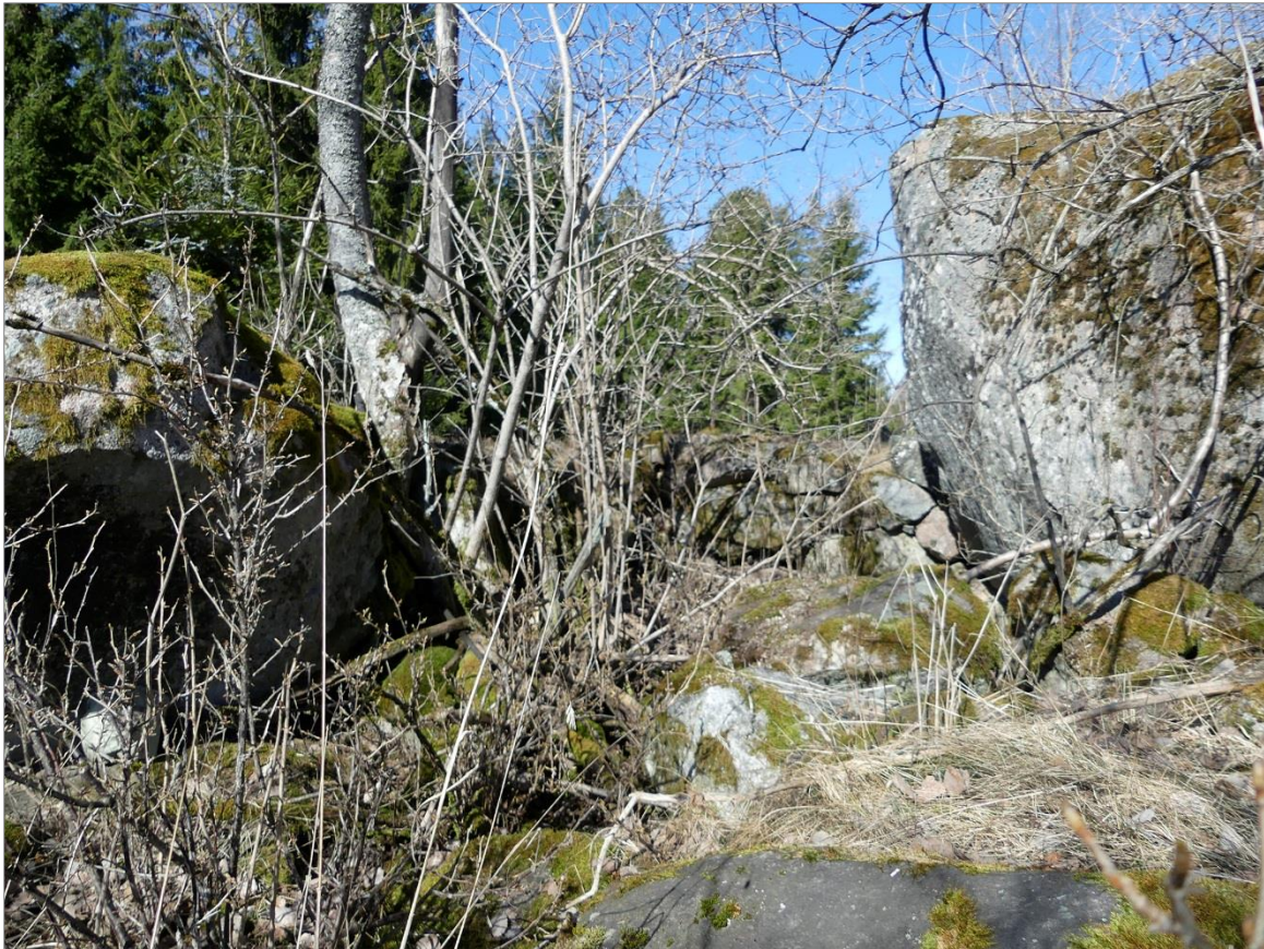
Figur 8. I källargrunden Uppsala 183:1 är en kallmurad vägg anlagd mellan två stenblock, vilken skymtas bakom vegetationen. Mot väster.
