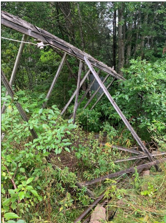
Figur 6. Rester av växthus på fastighetens södra del.
