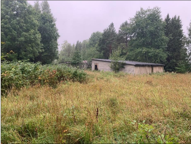
Figur 5. Byggnad 1 som sitter ihop med resterna av växthusen. Foto taget 2020-10-05 från fastighetens norra del i sydvästlig riktning.
