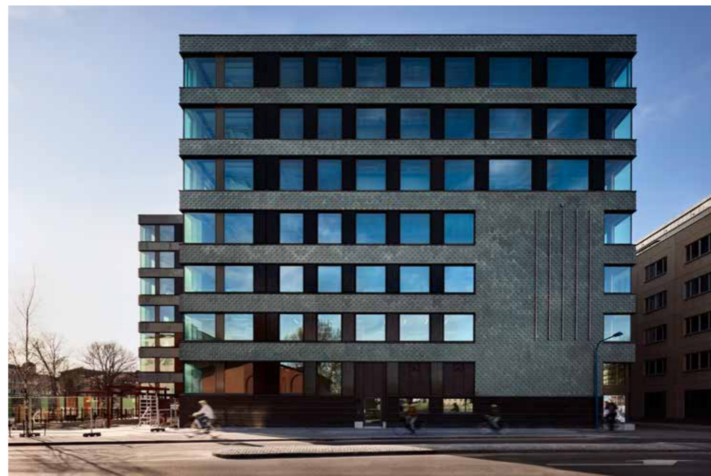
Lumi – en tillbyggnad med återbukad stomme. Källa: White arkitekter
