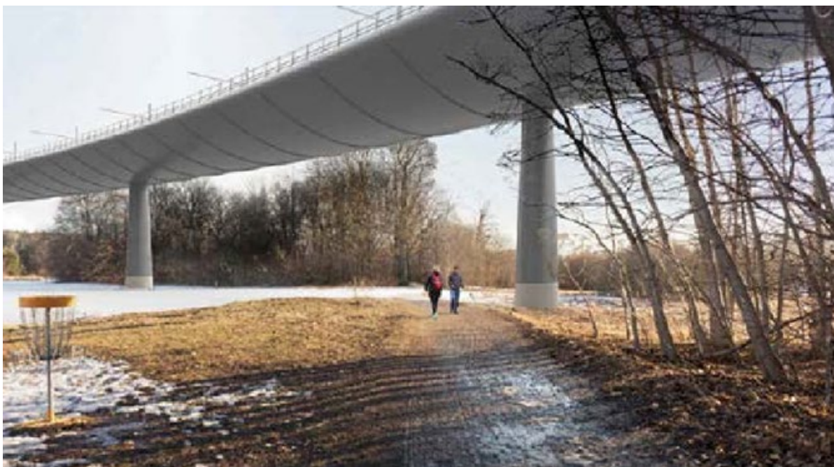
Figur 19. Fotomontage som visar broalternativ med 16 meter segelfri höjd. Utblick söder ut från Ultuna källväg, strax norr om bron. Bron fortsätter i vänster på bilden ut över Fyrisån. Bild av Rundquist arkitekter.
