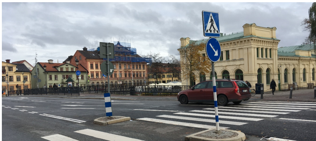
Figur 8 Pumphuset och Islandsbron, innan detaljplanens genomförande.
