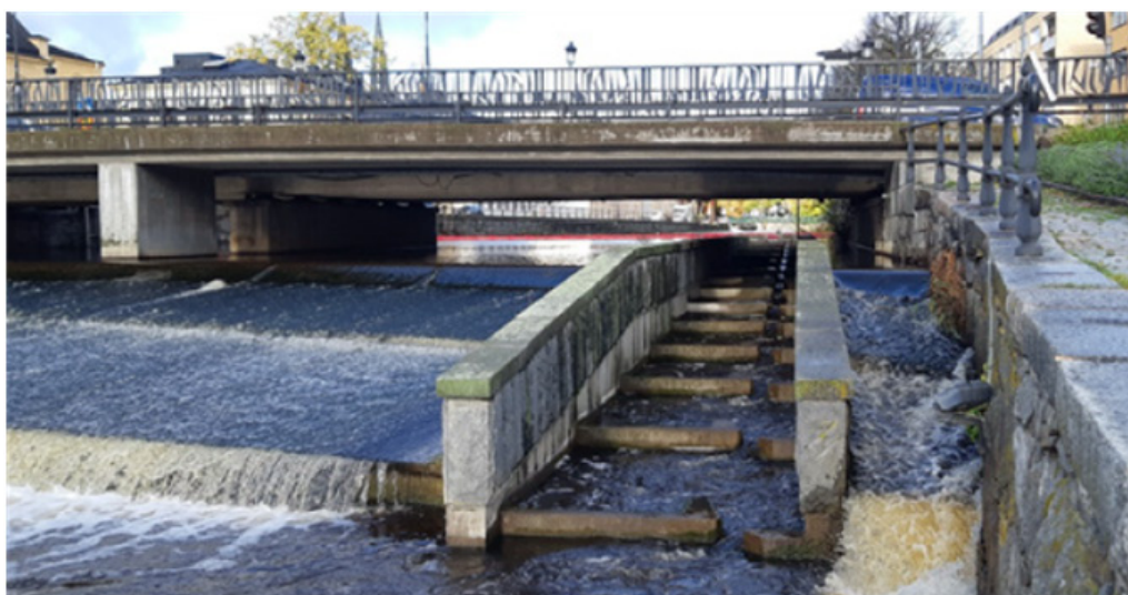
Figur 19 Fisktrappan under Islandsbron, främst för den vandrande fisken asp.
