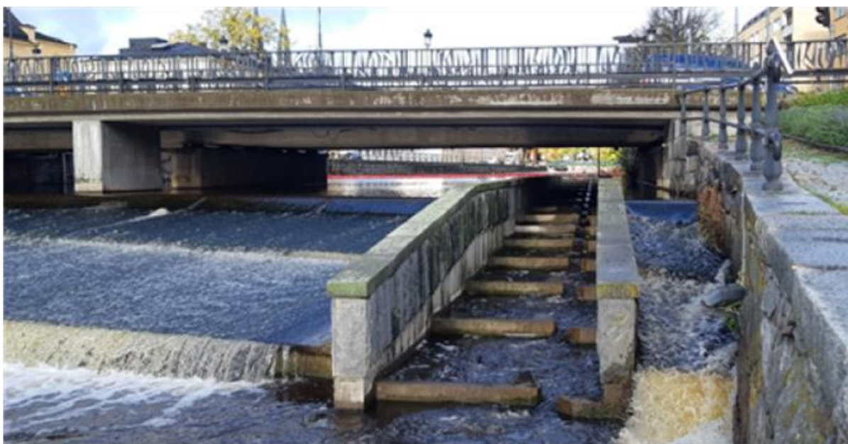
Figur 15. Asptrappan under Islandsfallet. Foto WSP Sverige AB
