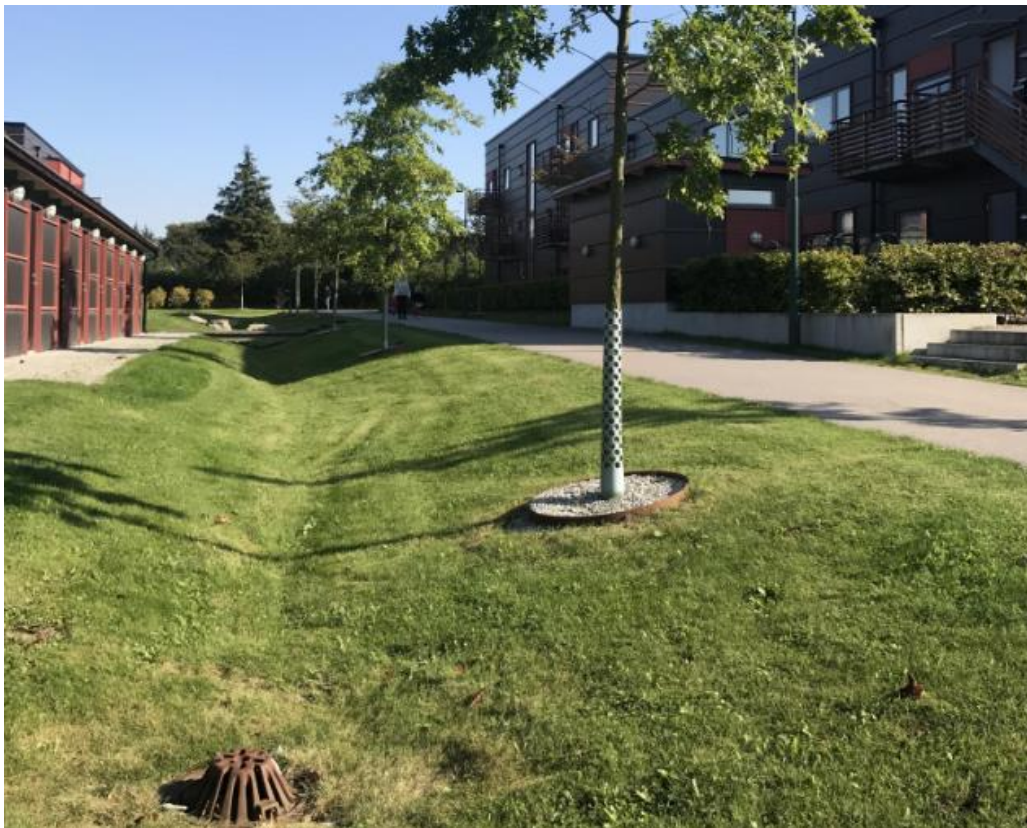
Figur 5-3. Ett svackdike i ett bostadsområde i Malmö. Foto: Structor Uppsala AB.
