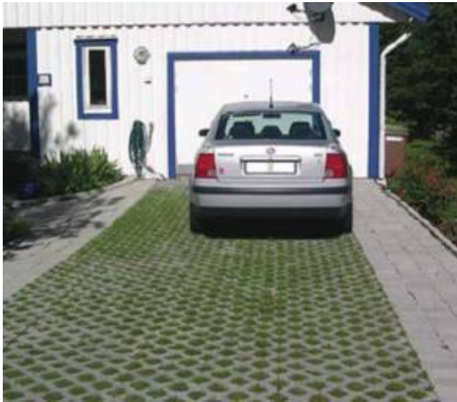
Figur 5-4. Exempel på en genomsläpplig parkeringsyta som lämpligen kan samordnas med ett underliggande makadammagasin.
