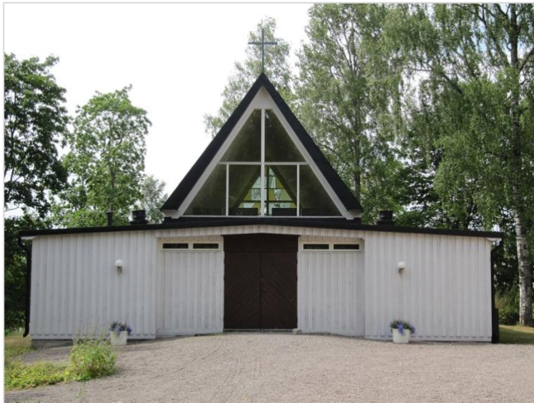
Örbyhus kyrka låg på Kvarngärdet fram till den nuvarande kyrkan uppfördes. Den så kallade vandringskyrkan är en av drygt trettio tillverkade av Oresjös fabriker AB som monteringsfärdiga byggsatser under 1960- och 70-talen. I Örbyhus fungerar den fortfarande som församlingskyrka. Foto: Ulf Klingström, www.wikipedia.org , hämtad 2024-09-28.
