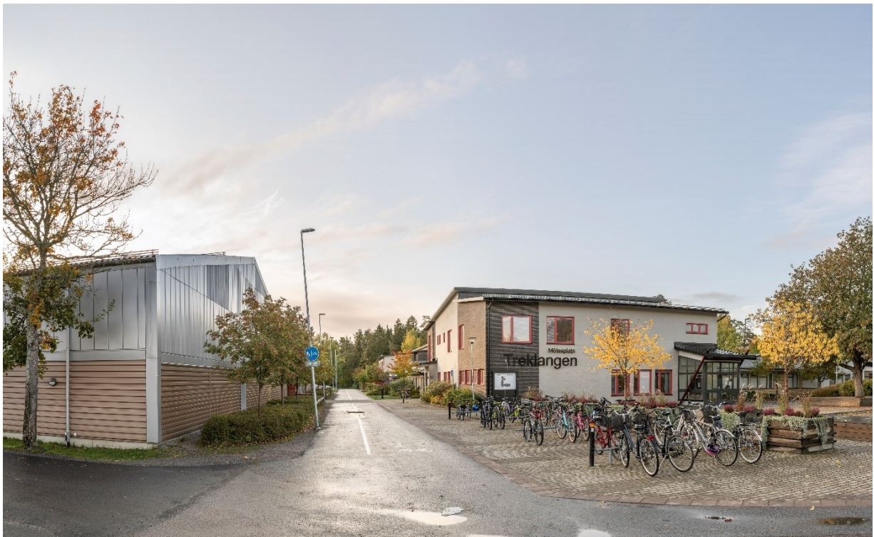
Figur 7 Gång- och cykelvägen Askbanan sedd från norr. Treklangens skola till höger i bild. Boule- och bollhallen till vänster i bild. (Anders Tukler)
