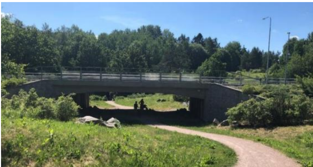
Figur 12. Gottsunda allé, broförbindelse över Gula stigen. Vy från norr (Uppsala kommun, 2024c).
