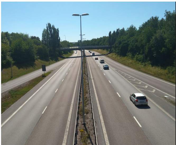
Figur 23. Bärbyleden västerut sett från gång- och cykelbro i Tunabackar.
